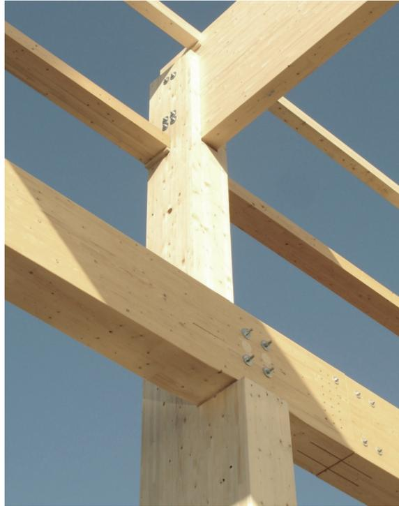
Holzstütze mit Ausklinkung für BSH-Kranbahn, blockverleimter Querschnitt: 480 x 990 mm Schwerlastkran bis 16 to.
