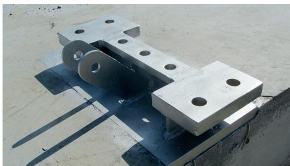
Holzstütze mit eingeklebten Gewindestangen, Schweißgrund in Fundament eingearbeitet, Fußstahlteil wird auf der Baustelle eingemessen und umlaufend verschweißt.
