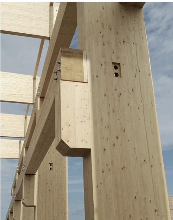
Auflagerkonsole in BSH-Ausführung, blockverleimte Kranbahn: 400 x 690 mm, Schwerlastkran bis 16 to.
