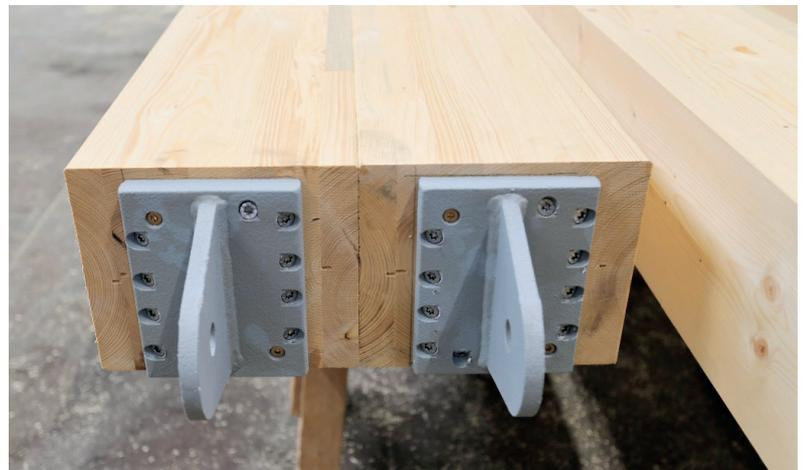
Verbandstahlteile, grundiert und R30 brandschutzbeschichtet, Deckanstrich RAL 7001
