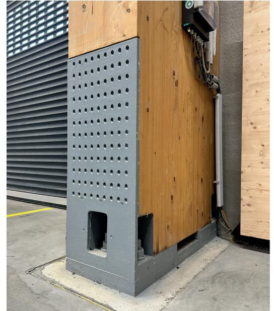
Pendelstützenfüße, grundiert und R30 brandschutzbeschichtet.
