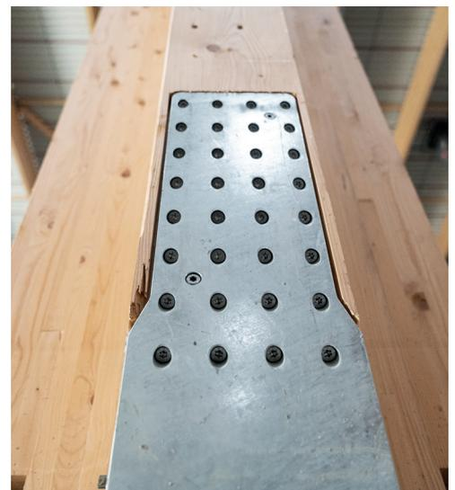
Detail eingespannte Holzstütze
