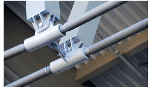
GVZ Ingolstadt: Gleisüberdachung, unterspannte Bogenträger, komplette Vormontage im Werk
