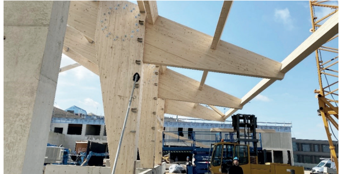
zweiteiliger Stiel, zweireihiger Dübelkreis mit Vordach
