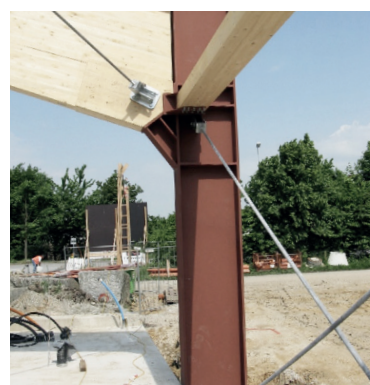
WIEHAG Rahmeneck mit Stahlstütze
