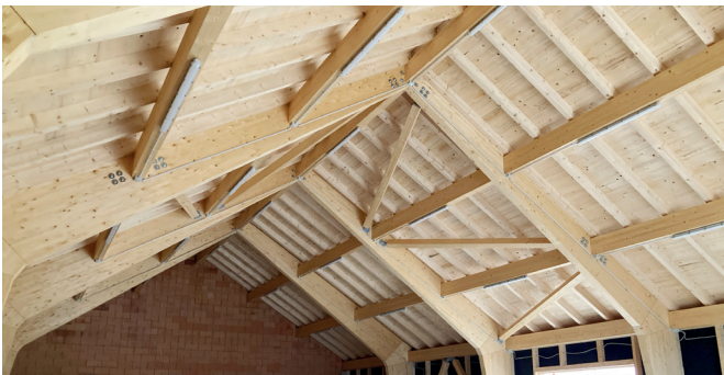
Sick Akademie, Waldkirch, keilgezinkte Rahmen als Dachkonstruktion
