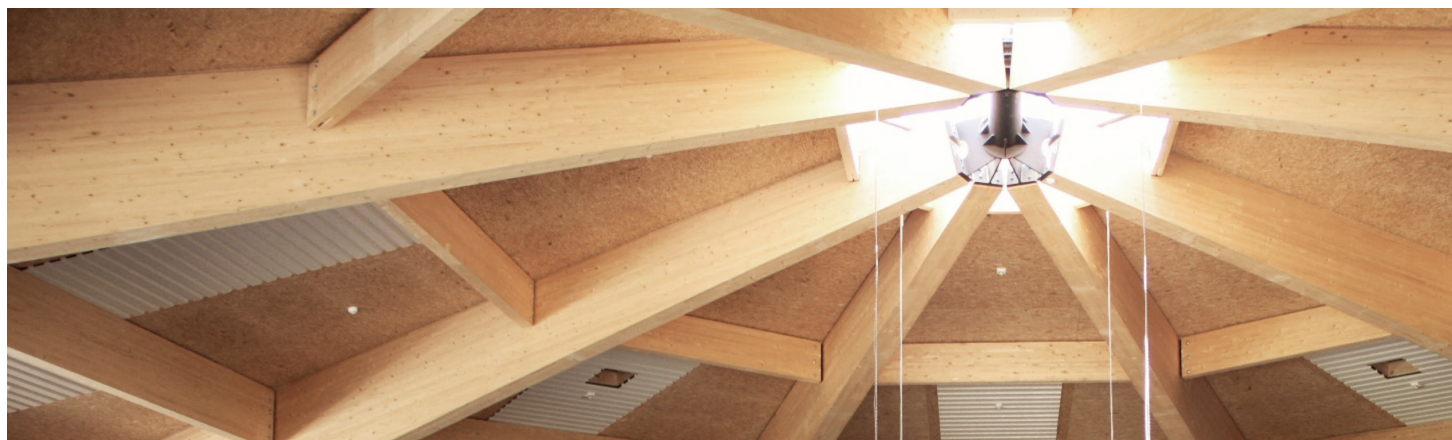
WIEHAG Rahmeneck mit zentralem Firstknoten
