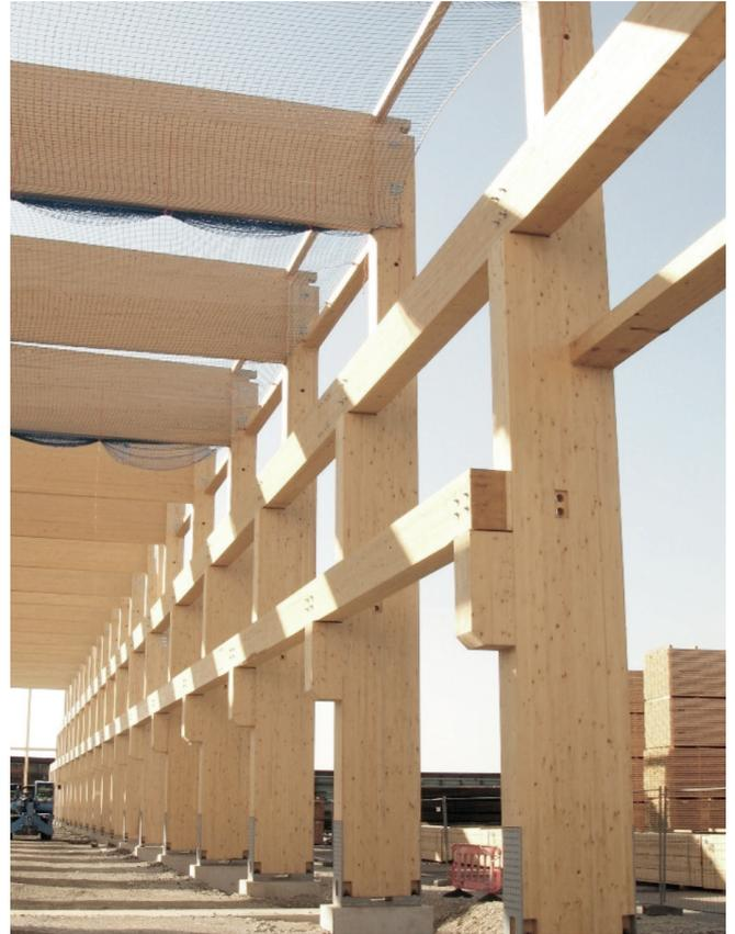
eingespannte Holzstützen und Kranbahnen
