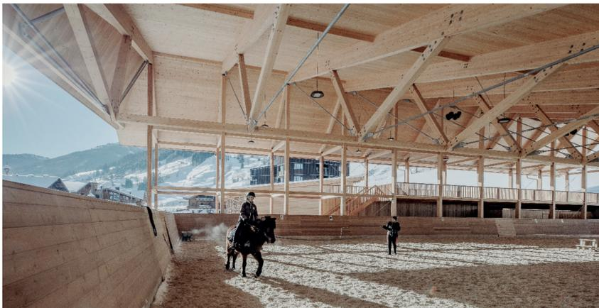
1) Giebeltragwerk aus Druckstreben und Brettsperholz
