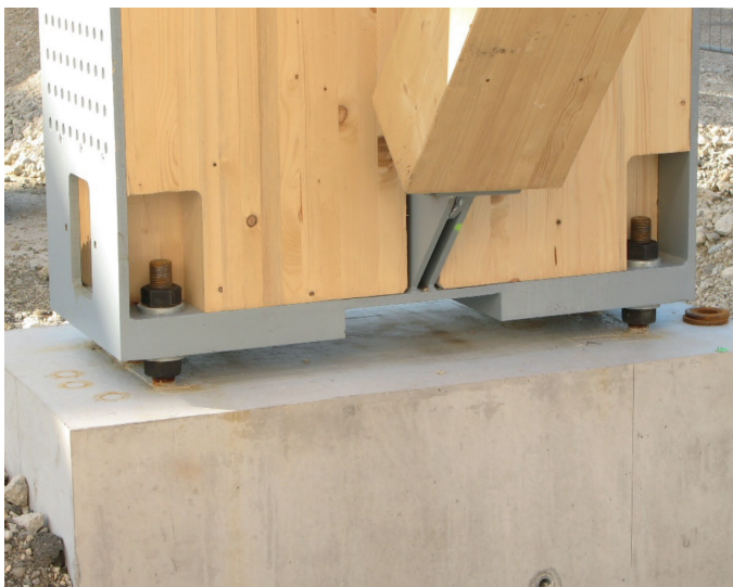
Eingespannte Stütze mit Verbandsanschluss
