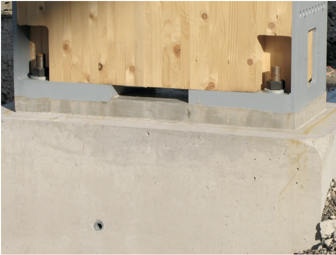
Formschluss mit Vergussbeton im Nachgang
