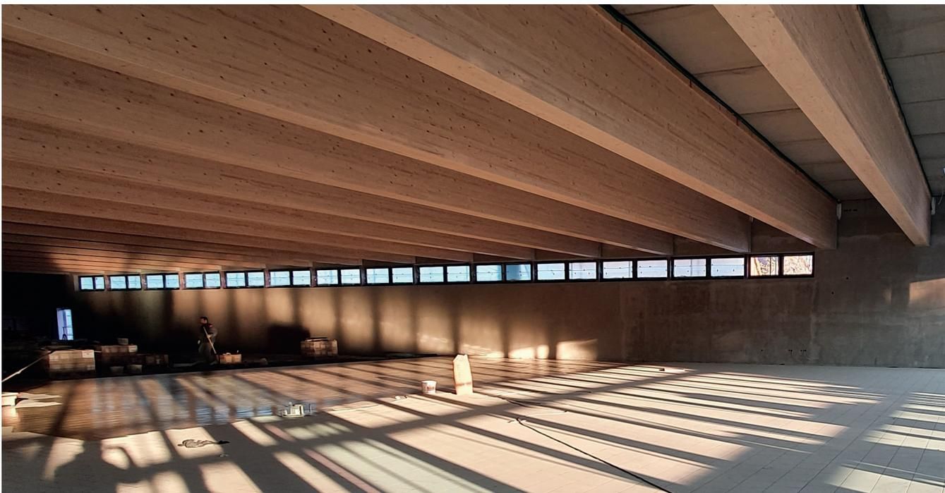
BSH – Konstruktion mit aufgebauter Filigrandecke
