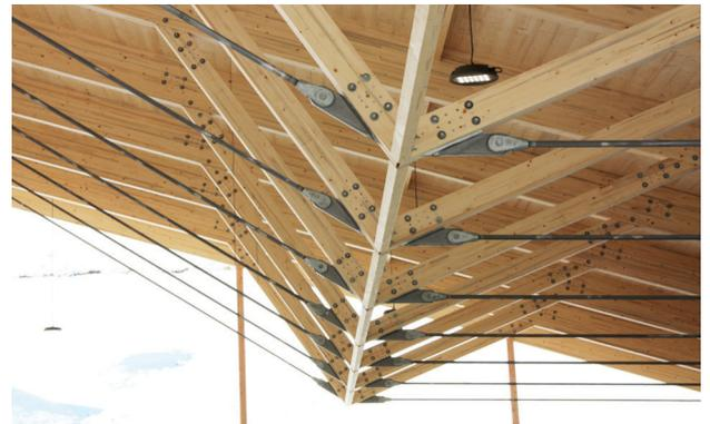
Reitplatzüberdachung, Großarl: unterspannte Parallelträger mit HMR Zugstabsystem
