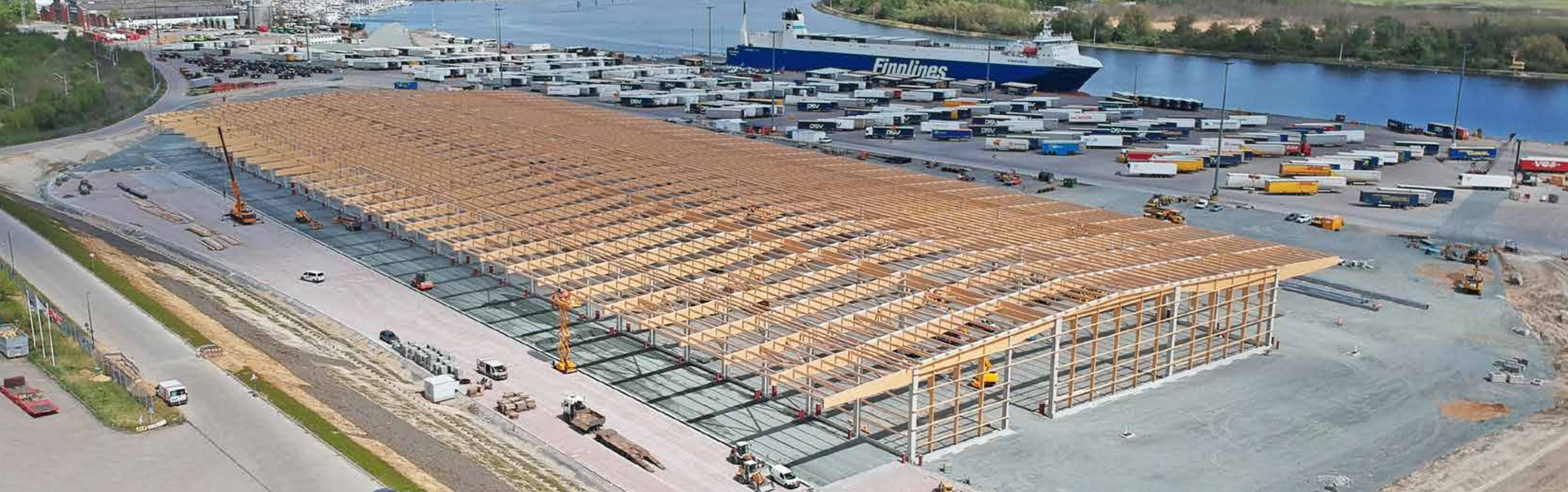
Skandinavienkai, Lübeck WIEHAG Holzbaupartner: Mohrmann Bau
