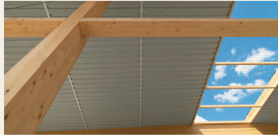
Produktionshalle Tischlerei Kieslinger, Sigharting (A)
