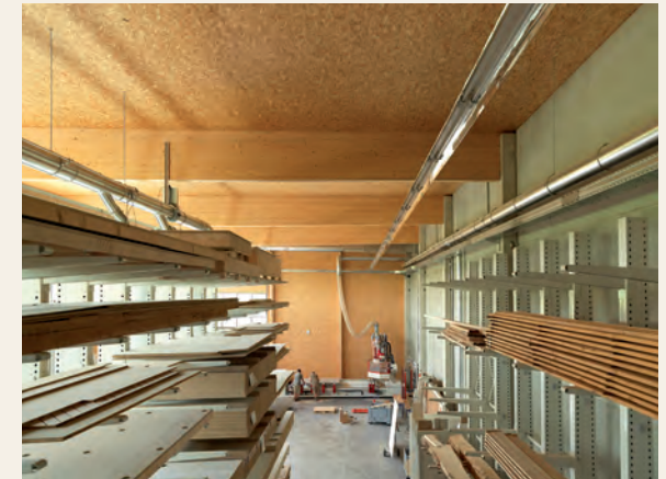
Produktionshalle Josef Kellnberger Bau- und Möbelschreinerei, Künzing (D)
