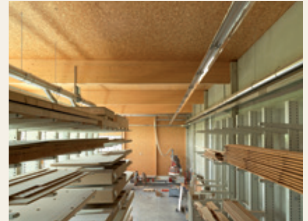
Production shop for Josef Kellnberger Bau- und Möbelschreinerei, Künzing (D)
