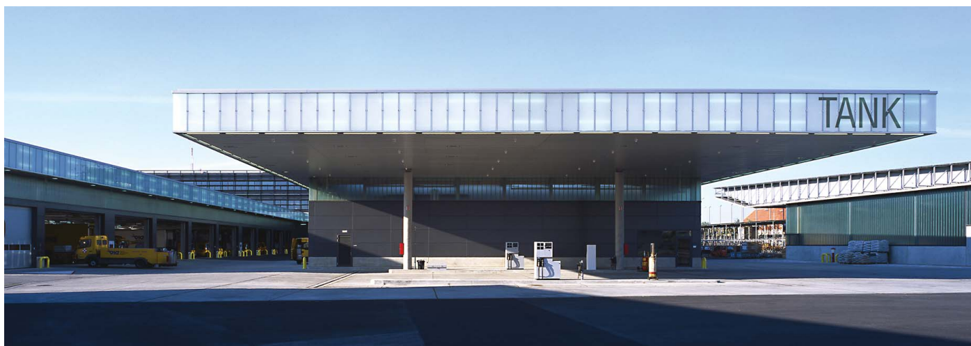
Bild 1 Imposant: Das Dach der Flughafen-Tankstelle kragt nach vorne 15 m und seitlich jeweils 7 m aus. Die zwei „Stützchen“ im Hintergrund „verlieren“ sich beinahe unter der Fläche.
