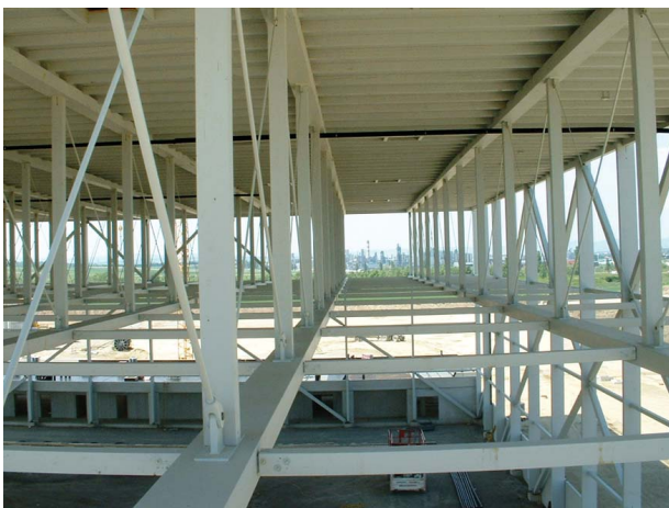
Bild 15 Blick in die Binderebene, ziemlich wenig Holz bei 75 m Stützweite und (noch?) ungewohnt die „flach“ liegenden Bindergurte
