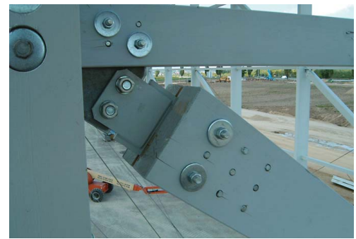
Bild 14 Knoten der Wandverbände: Die Baustellenverbindung mit Stahl-Stahl-Bolzen-Anschluss erleichtert die Montage ungemein.
