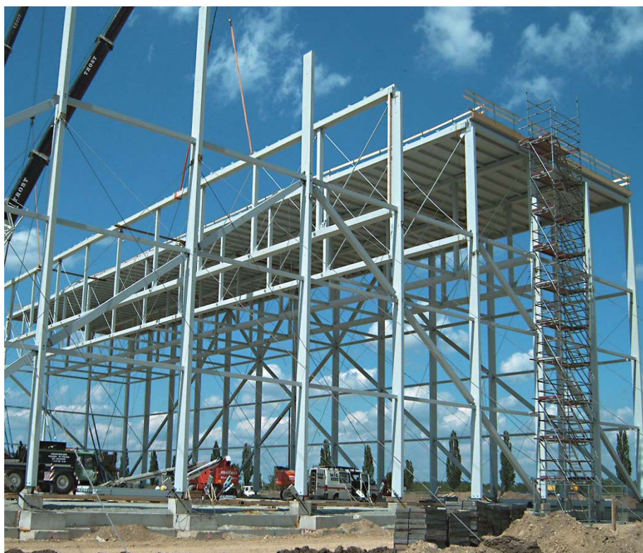
Bild 2 Der VIP-Hangar beim Hebau: Stützweite 75 m, Länge 60 m, Höhe 20 m
