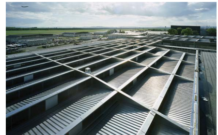
Bild 4 Das ACC-Dach aus der Vogelperspektive
