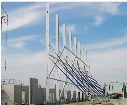
Bild 12 Das will gekonnt sein: Stellen der ersten Stützenreihe, 20 m Stützenhöhe, oben muss es nachher passen.
