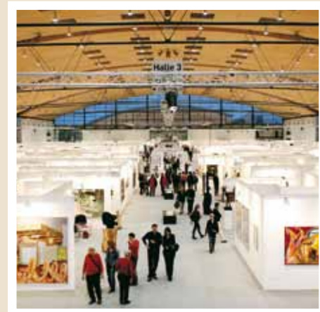
Area fieristica di Karlsruhe - 80 m di struttura autoportante ad arco in combinazione con Profiplan WIEHAG (utilizzato come intradosso portante e a vista per solaio)
