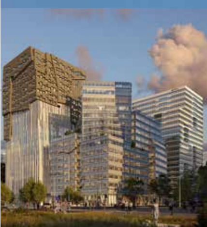
The CubeHouse, Amsterdam Zuidas Developer: G&S&G, Builder: Visser & Smit Bouw www.the-cubehouse.com
